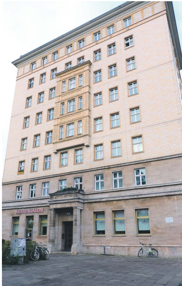
Objekt der Begierde: Karl-Marx-Allee 100
