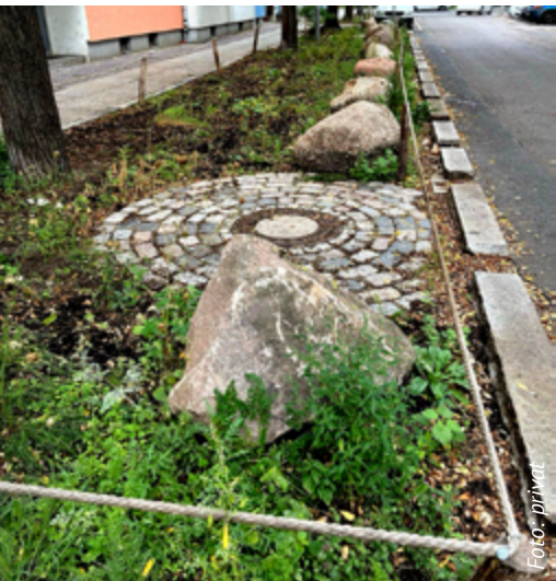
Ein grüner Gully in der Ruhlsdorfer Straße
